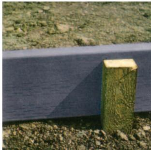
Les **fentes d'entrée** sont usinées au bas des éléments. Cette disposition est le fruit d'une longue expérience en matière de drainage et est en tout conforme aux lois de l'hydraulique. Le coffrage-drain est à placer de telle sorte que les fentes d'entrée soient dirigées vers le bas et vers l'extérieur.
