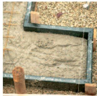
Les profilés **FSD** doivent être emboîtés à fond dans les manchons et les coins **FSD** pour assurer le bon fonctionnement du drainage.
